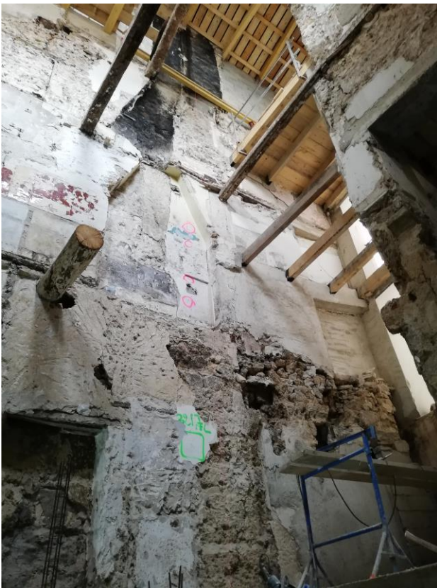
Création de la cage d'ascenseur. 2024 09 24
