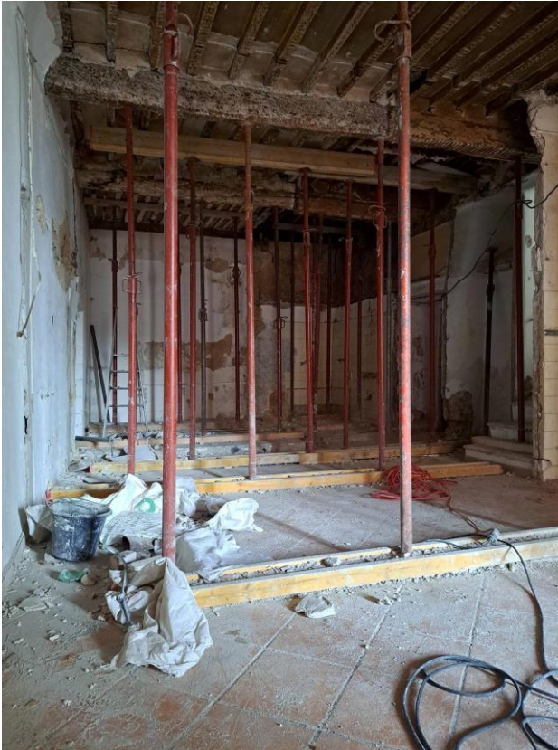
Etalement avant démarrage des travaux. 2022 12 22.
