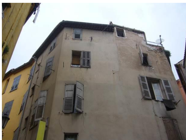
Etat avant travaux
