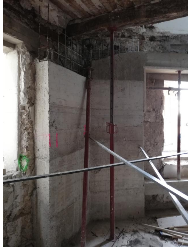
Travaux de reprise structurelle. 2023 12 21.
