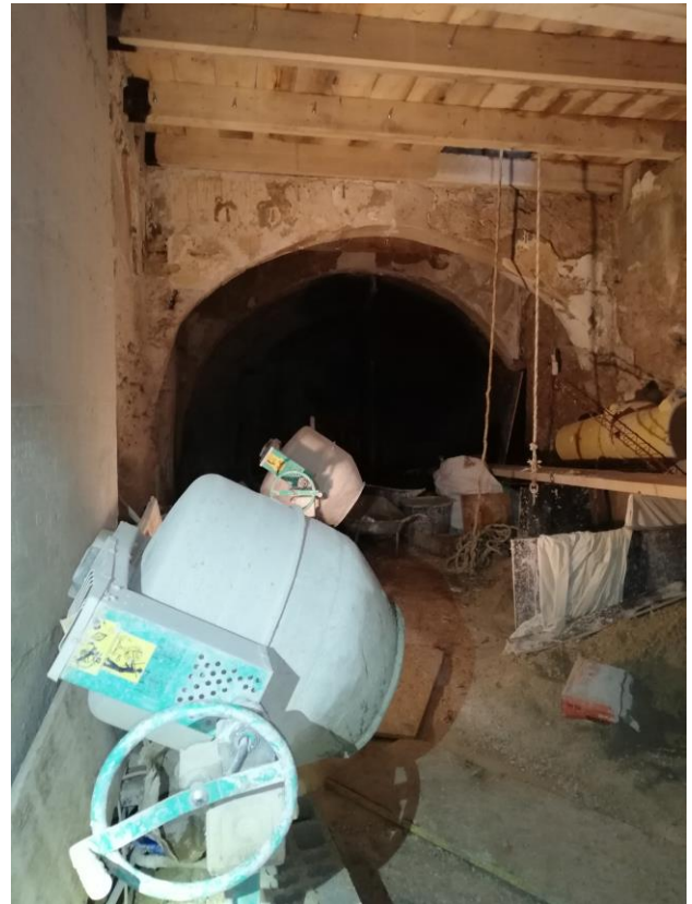
Travaux rez-de-chaussée bas. 2024 09 24
