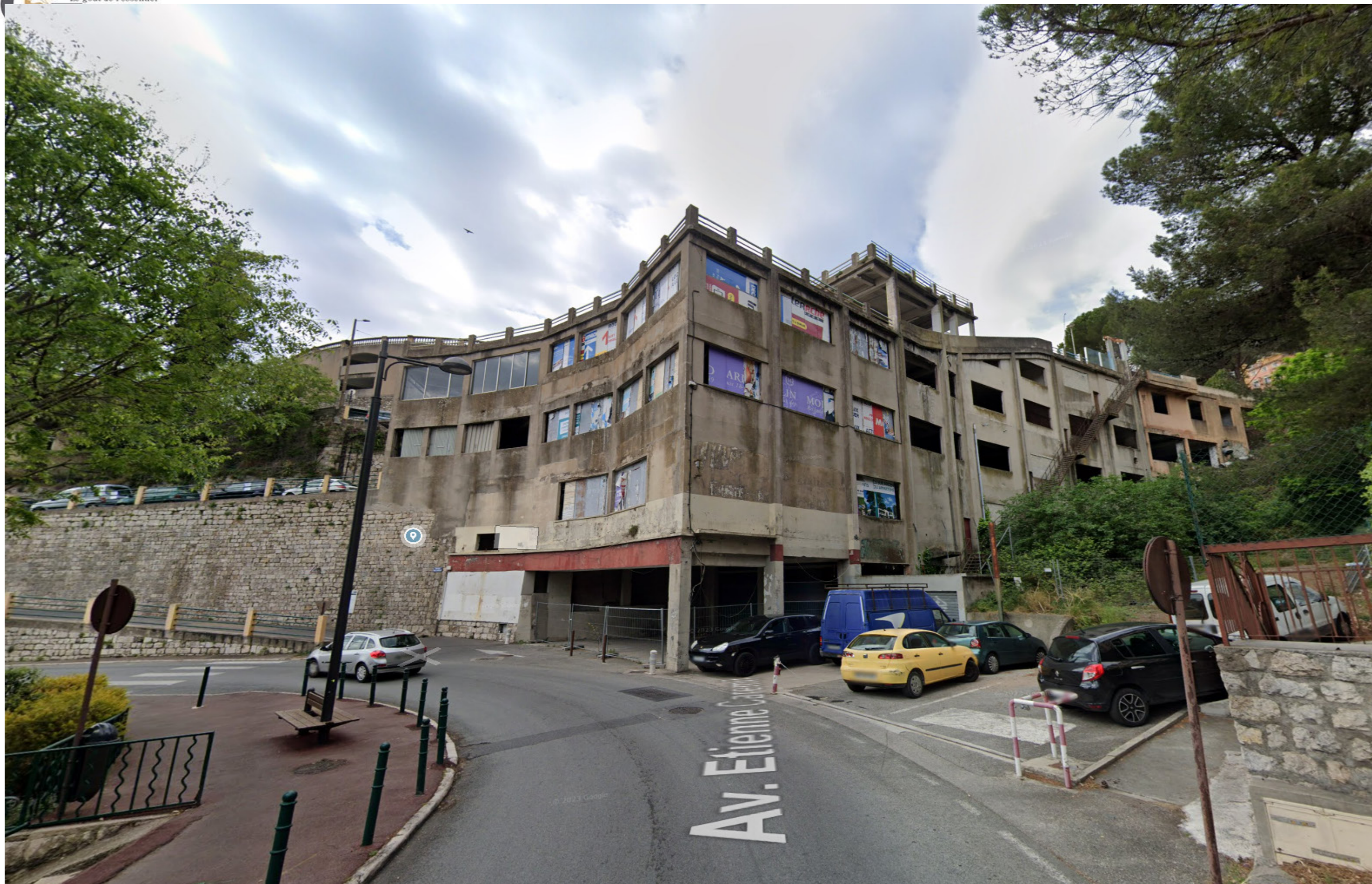
ÉTAT ACTUEL DEPUIS LE BOULEVARD GAMBETTA
