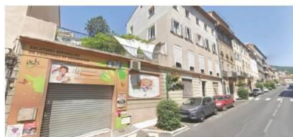
RENOVATION & MISE EN VALEUR
